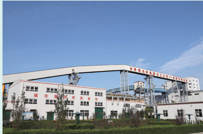
圖5-35定州園區城市集中供熱首站
